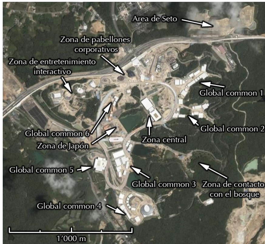
Imagen 1. Vista aérea del recinto de la Expo 2005 Aichi 447
